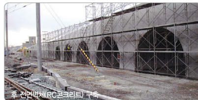
후 전면벽체(RC콘크리트) 구축
