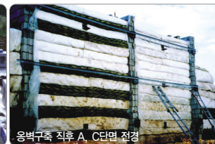
옹벽구축 직후 A, C단면 전경
